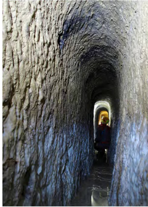
Fig. 9. Acquedotto di Fonte Cantaro: cunicolo principale.
