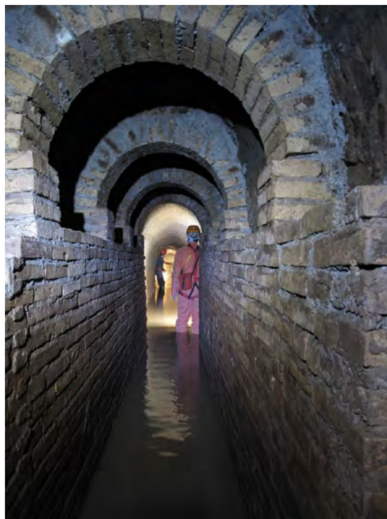
Fig. 1. Acquedotto della Fonte del Pozzo: condotto principale restaurato.
