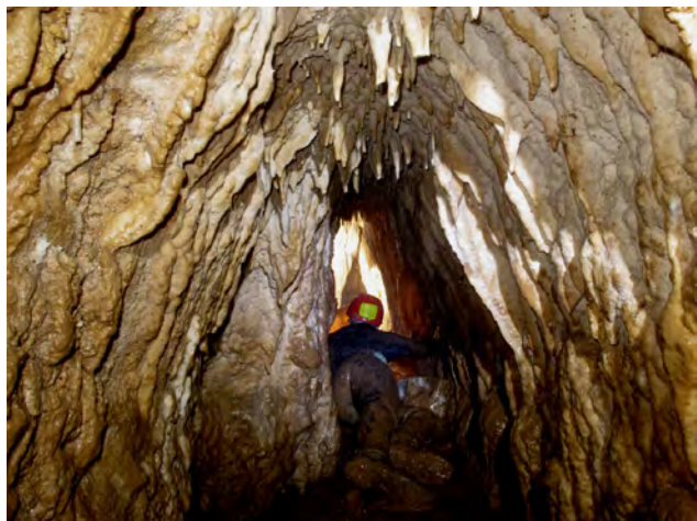
Fig. 6. Acquedotto di Riancoli: condotto principale e depositi di calcite.
