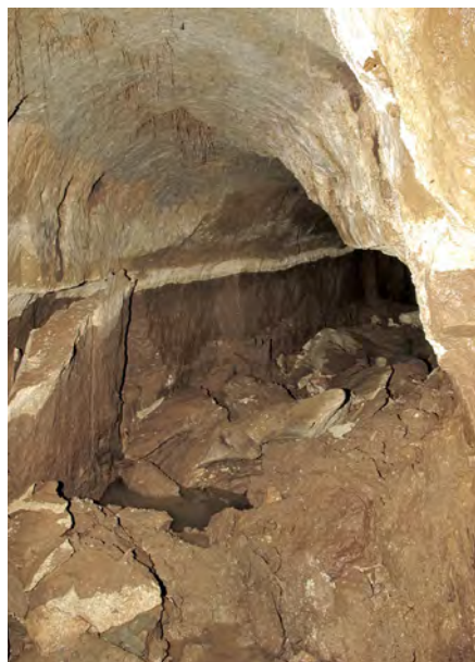
Fig. 3. Condotto di adduzione idraulica secondario: alternanza di strati tufacei e argillosi.
