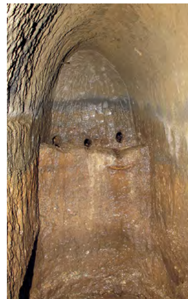
Fig. 5. Particolare con i fori da cui fuoriesce l'acqua che alimenta l'acquedotto.
